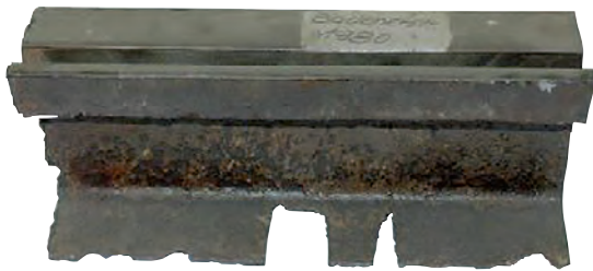
Streustromschäden an Rillenschienen
