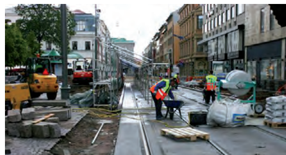
Bei einer Doppelhaltestelle in Göteborg wurden die beiden Systeme INDUCRET®-VK-Monolith und INDUCRET®-VK-Fug erfolgreich realisiert.
